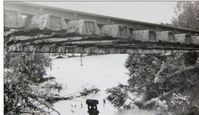
Zerstörte Bahnbrücke unterhalb Töppeln, ehemalige Höhe des Gleises über Gelände: 15 Meter (Aufnahme vom 10.08.1981, 15Uhr)
