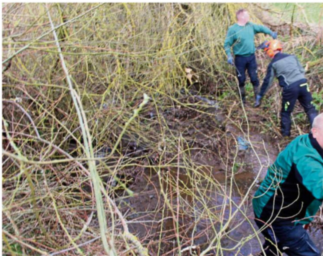
Thomas Credo, Sascha Klöppel und René Degenhardt (von rechts) vom Gewässerunterhaltungsverband sind bei den Buschungsarbeiten am Bach Sete in Limlingerode.
